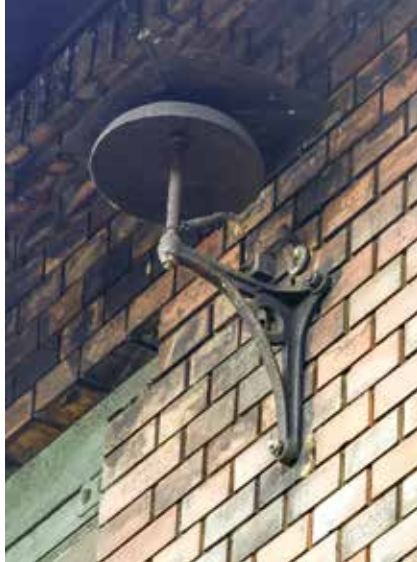
6. ábra: Falra szerelt harangjelző ütőműve
