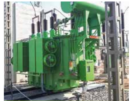
1. kép: 16 MVA teljesítményű vontatási transzformátor
