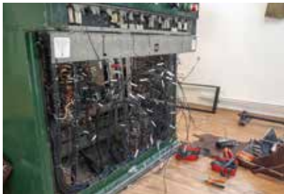
A VES berendezés állítókészülékének huzalozása
