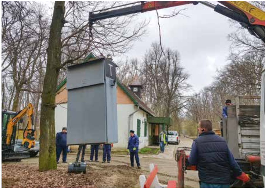
Az ideiglenes sorompószekrény beemelése
