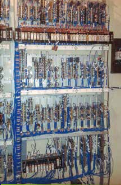
A VES berendezés régi állványhuzalozása
