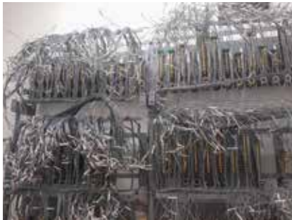
A VES berendezés előhuzalozott állványai
