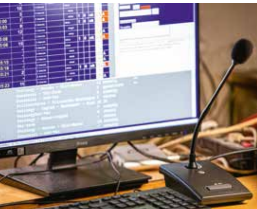
16. kép: Bemondóhelység – telepített üzemi és vészbemondó pultok
