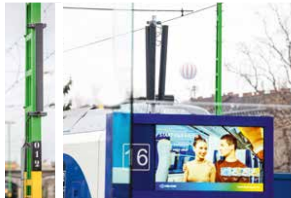
13. kép: Kültéri peronokon telepített Biamp COLW101 vonalsugárzók
