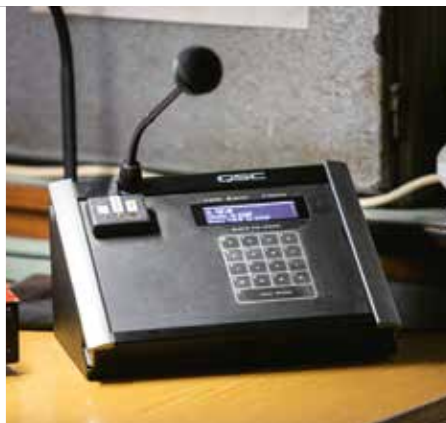
16. kép: Bemondóhelység – telepített üzemi és vészbemondó pultok
